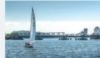
Nadelöhr an der Schlei: die Eisenbahnbrücke Lindaunis
