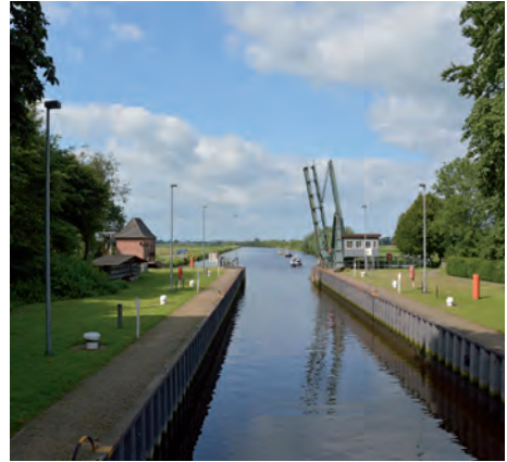
Die Zukunft ist alles andere als sicher: Die Schleuse mit Klappbrücke am Gieselaukanal.
